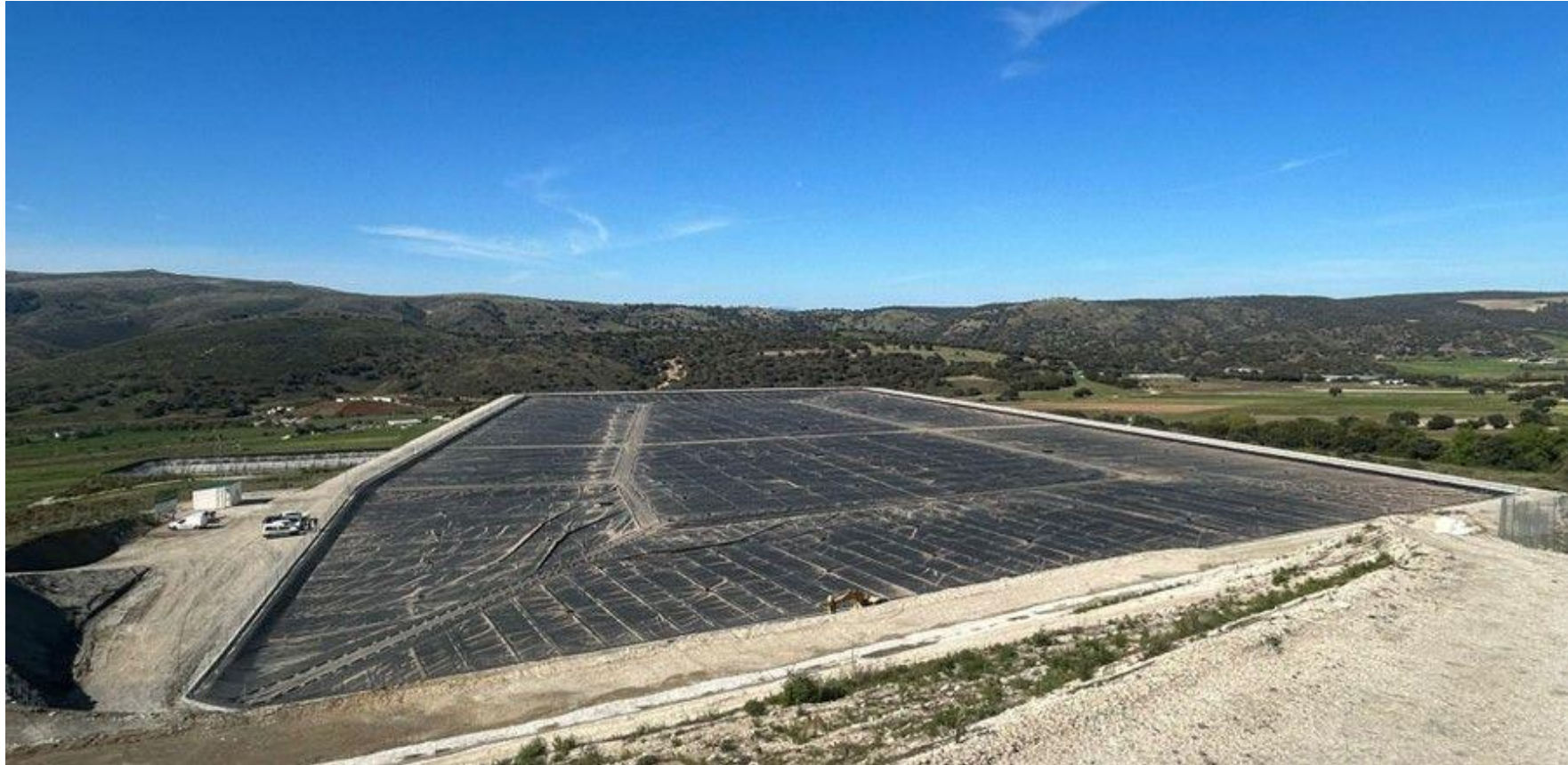
Balsa y cubierta flotante de la Comunidad de Regantes de “La Volaera” Zafarraya, Granada
